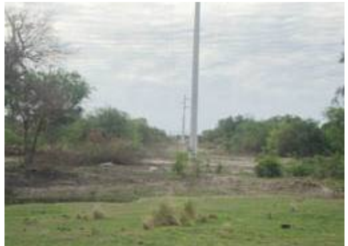
Piquete 332. Hacia el fondo, entrada a la Estación Transformadora Las Lomitas
