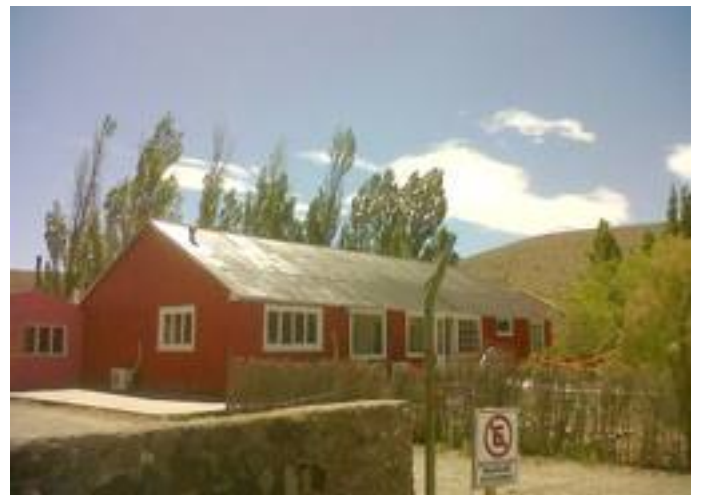
Obrador de Teyma Abengoa en Cerro Negro. Estancia María Aike
